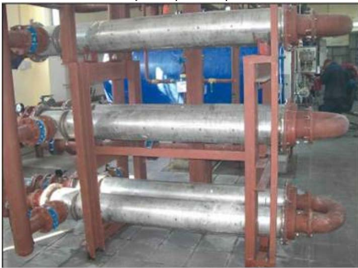
Рисунок 8 - Теплообменники ВВПИ в котельной МУП «Теплосервис»
